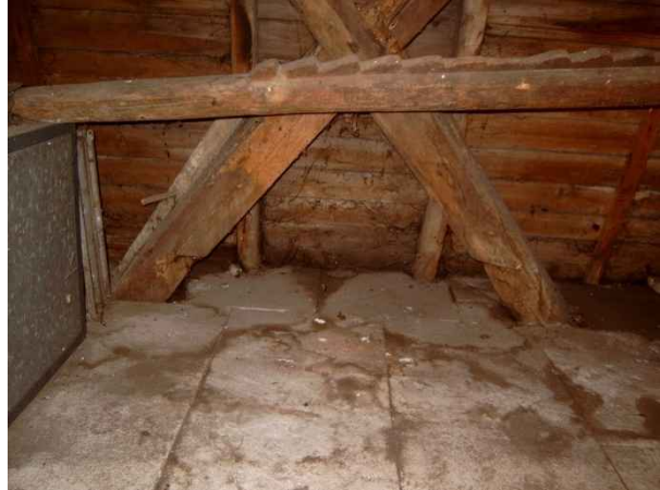
Ausnehmungen für ehemalige Mehlmischmaschine im Anderskreuz über dem Fußboden.
