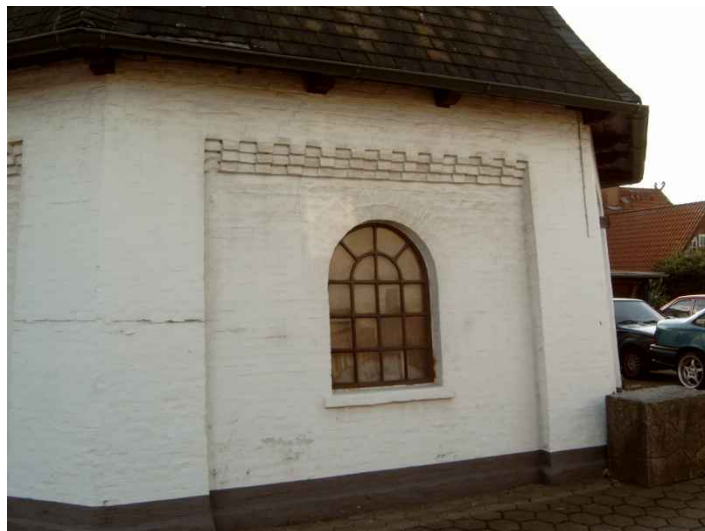
Mauerwerk des Unterbaus mit Ecklisenen und schön gestaltetem Fries.
