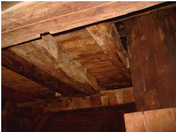
Deckenbalkenwerk mit Ausnehmungen für ehem. Hängewerk der Aufzugswinde sowie mittig halbrunde Ausnehmung für ehem. zugehörige waagerechte Antriebsscheibe.
