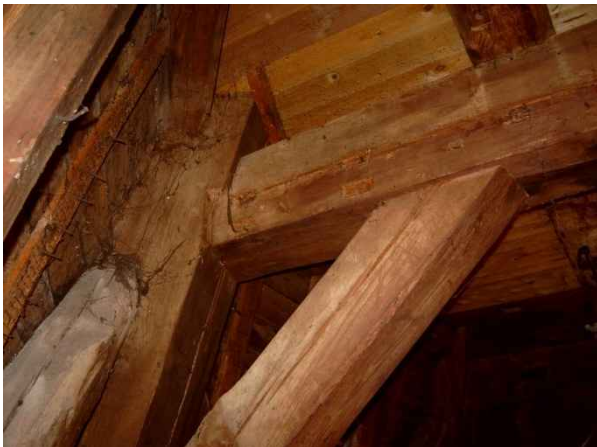
Spuren vom ehemaligen Vorbehälter des Walzenstuhls im Balkenwerk an der Südwestseite.
