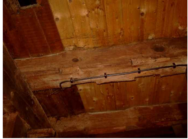
Deckenbalkeneinkerbungen von ehemaligem Annahme-Elevator über der Transmission.
