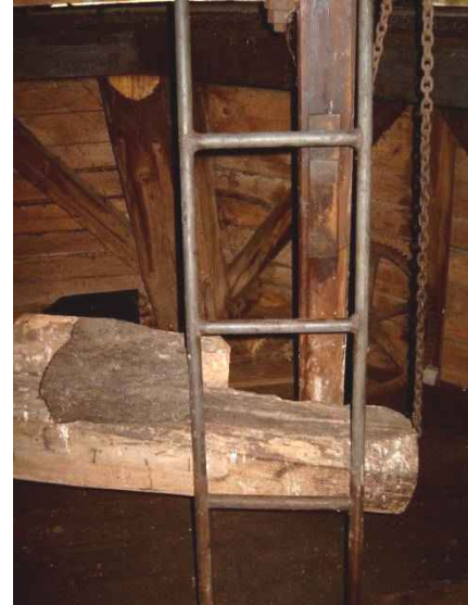
Hinteres Ende des Bremsbalkens mit Einklinkmöglichkeit in sog. „Daumen“. Dahinter steht das Stirnrad vom ursprünglichen Windrosenvorgelege.
