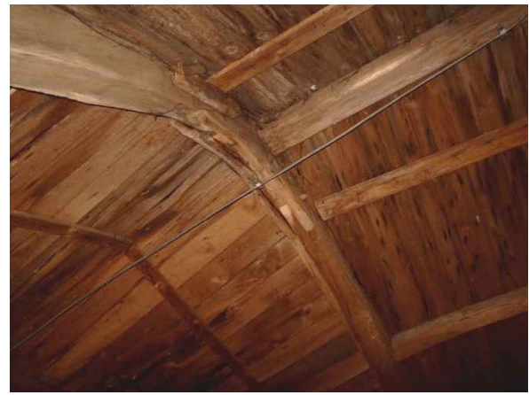
Verbindung des hinteren Dachsparrenpaares am First.
