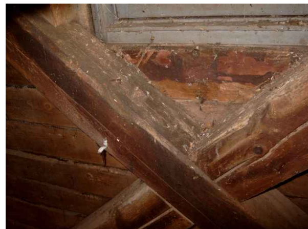
Andreaskreuz an der Ostseite mit Ausnehmung für Lagerbock der ehem. Sackwinde.
