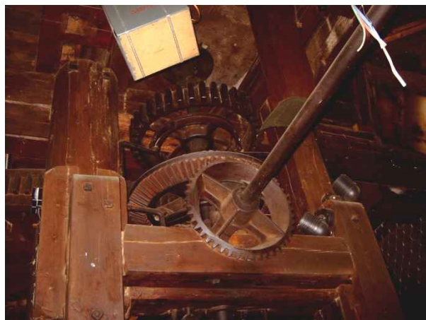
Eisernes Ritzel zum Betrieb des Backschrotgangs mit Kegelradvorgelege für Motorantrieb, links Ständer vom Tragwerk der Königswelle.
