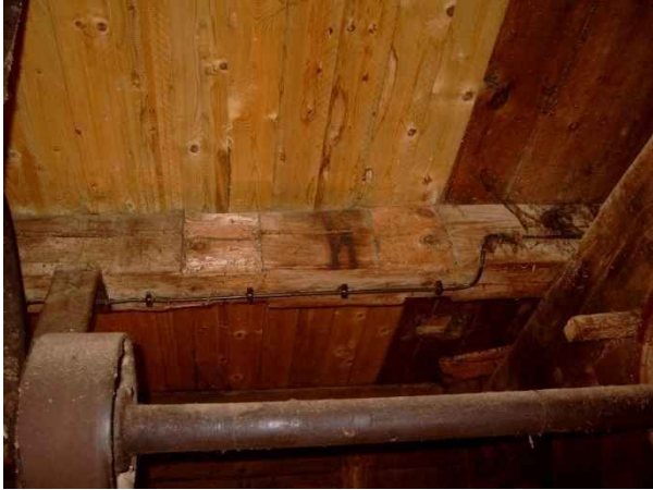
Ausnehmungen für ehemaligen Annahmehievenator im Balkenwerk über der Transmission.
