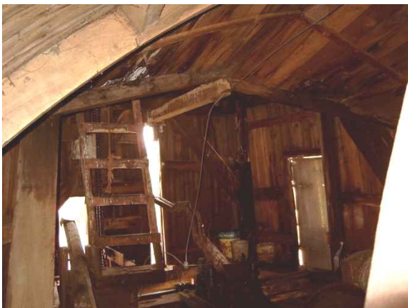
Gesamtansicht des Hintergiebels mit verkleidetem Windrosenbock.
