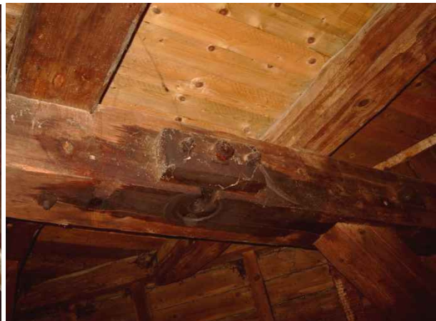
Oberes Lager der ehemaligen Nebenkönigswelle, an der Balkenunterseite Spuren des Kegelrades zum Abtrieb auf die Transmission sowie Bolzenlöcher für Lagerbock derselben.
