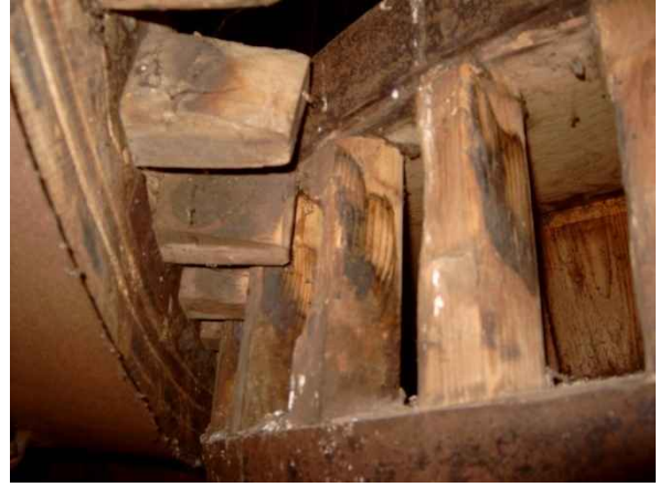
Schlechter Eingriff des Kammrades i. d. Bunkler.
