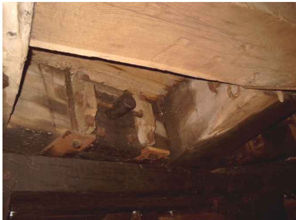
Zwei Lagerböcke mit Stützrollen auf dem Drehkranz unter dem Halslager der Flügelwelle.
