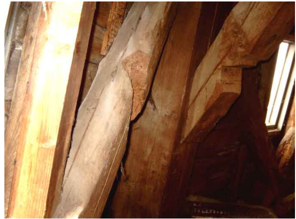
Spuren vom ehemaligen Vorbehälter des Walzenstuhls im Balkenwerk an der Südwestseite.
