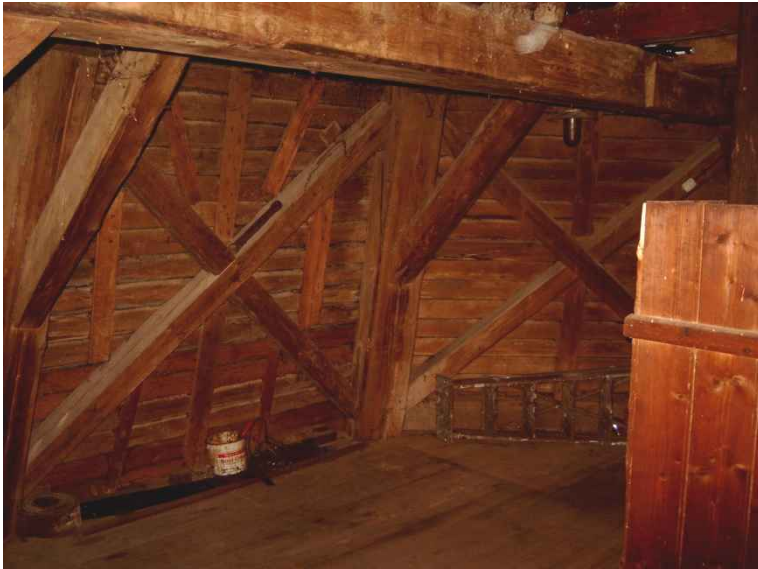
Wandkonstruktion mit Eckständern und Andriaskreuzen.
