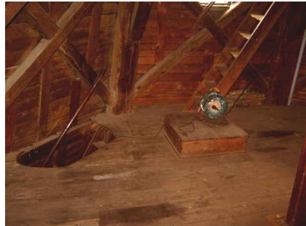
Treppen zum Lagerboden und zum Kappboden, mittig Schütttrichter zum Futterschrotgang.
