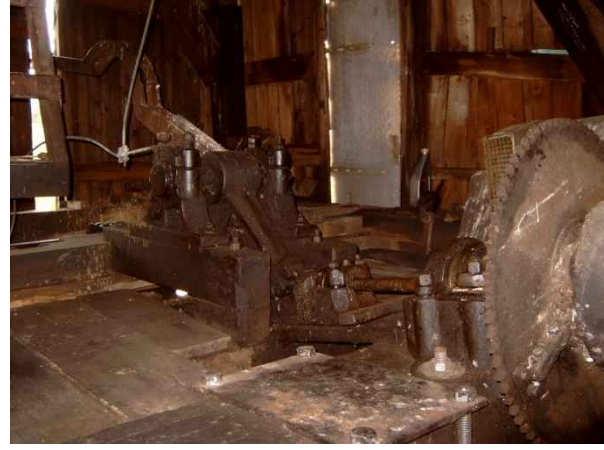
Jalousiesteuerung hinter dem Penende der Flügelwelle.
