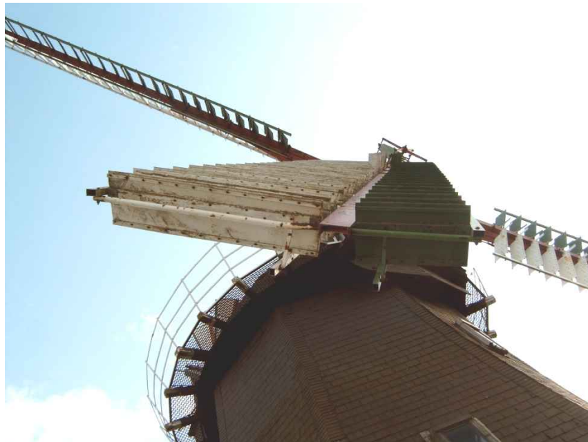
Profil eines Flügels mit extrem geringer Verschränkung.
