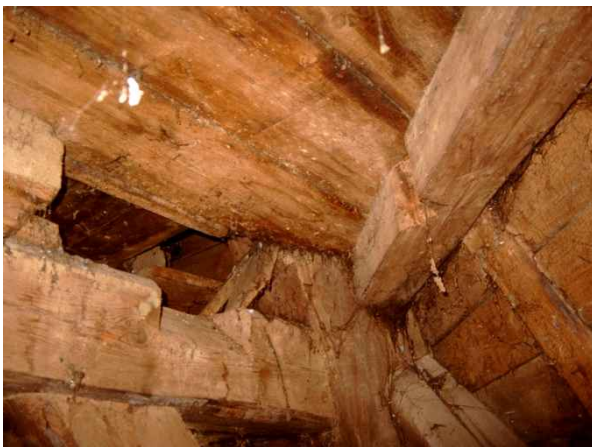
Schlagbalken, Eckständer und Riegel an der Westseite mit Ausnehmung für ehem. Rohr zur Backschrotmischmaschine.
