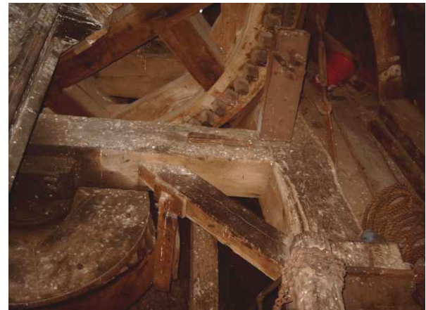
Rechter Fugbalken des Kapprahmens mit Eisenbalken und Schrägaussteifung.
