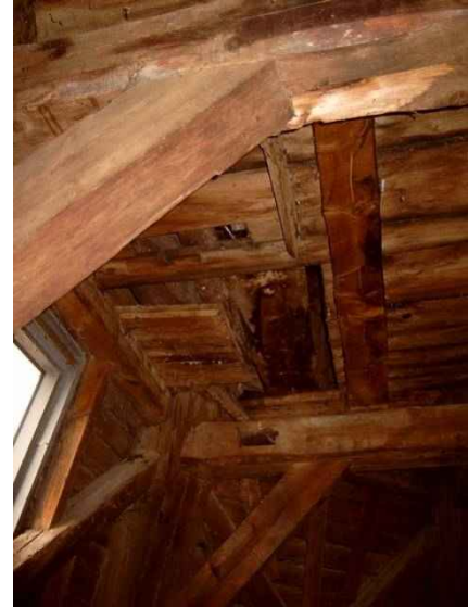
Deckenbalkenlage an der Westseite mit Bodendurchbrüchen für die ehem. Elevatoren.
