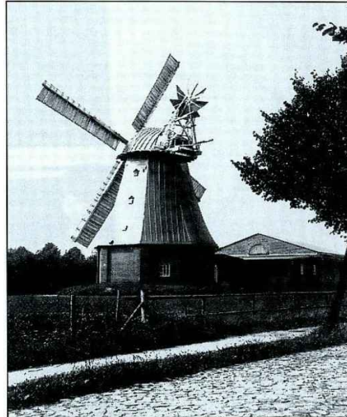
Regulatorenanlage und Radstuhl Hittfeld
